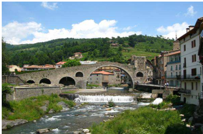
Pont romànic de Camprodon sobre el Ter
