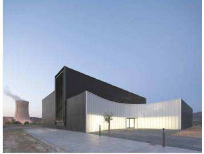
Vista exterior del Centre d'Interpretació de la central
