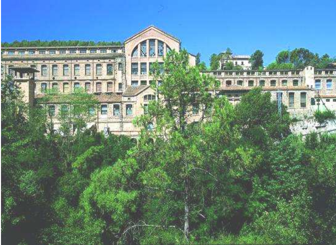
Fàbrica tèxtil de Cal Pons
