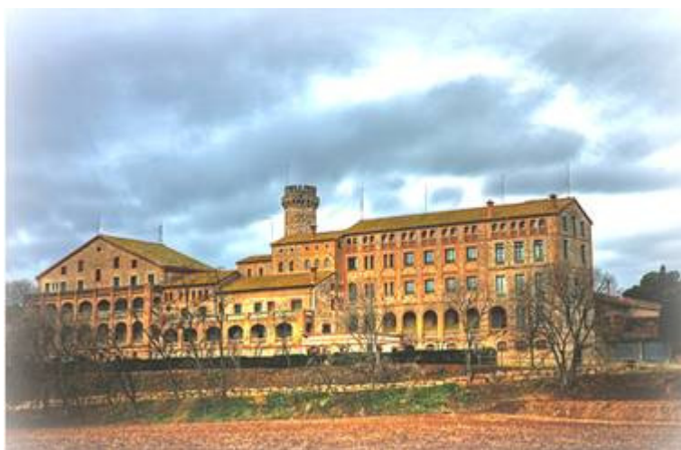
Torre Marimon de Caldes de Montbui
