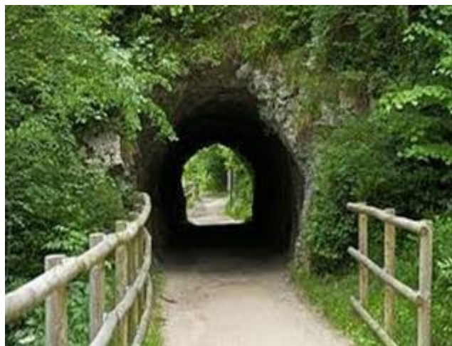
Túnel de l'antic tren miner
