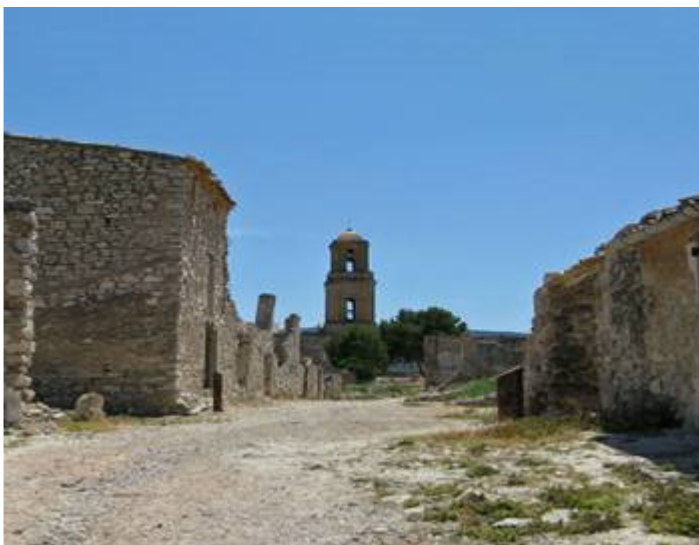
(Poble Vell) Corbera d'Ebre, derruït
